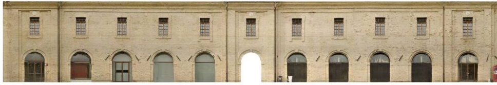
Figura 14. Ortofoto del prospetto sud - ovest, lato esterno del Lazzaretto. La facciata, restaurata a partire dal 1997, mostra gli ordini del corpo di fabbrica e la scansione delle murature mediante paraste che incorniciano le aperture centrali e di estremità.
