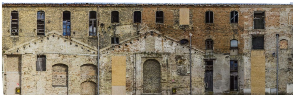
Figura 13. Ortofoto del prospetto sud - est, lato interno del Lazzaretto. Sulla facciata sono identificabili chiaramente le tracce di una delle fasi storiche del Lazzaretto: la manifattura tabacchi. I segni presenti sulle murature indicano lo spazio che, dal 1947 al 1997, è stato occupato dai magazzini.
