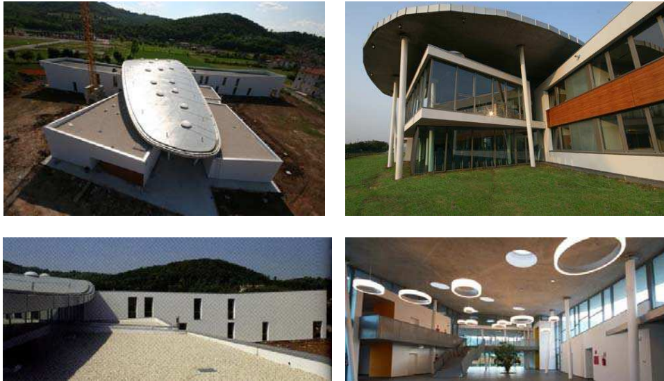
Fig. 1-32 First Grade Secondary School in Isola Vicentina, Vallorcola Place, province of Vicenza. External and internal views, (Source: Arketipo [2017], Scuola Secondaria di Primo Grado , Architectural Magazine n.112/17, Istruzione/Education, New Business Media srl, Milano, pp.124-125).
