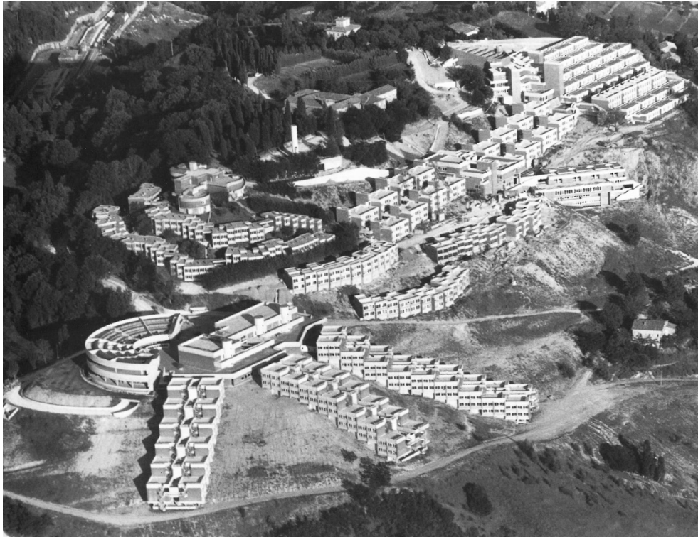
Fig. 2-15 Aerial view of Collegi Universitari, Urbino, Italy. Building by Giancarlo De Carlo, 1962-1981. (Source: Università' Iuav di Venezia, Archivio Progetti, Fondo De Carlo).
