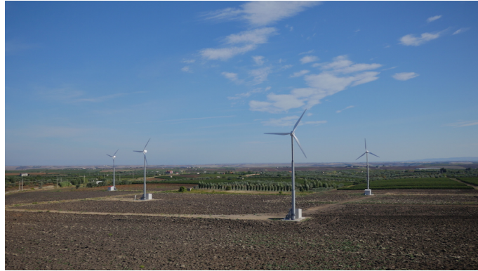
Figura 2.16: Fotografia di parco eolico con aergeneratori di piccola taglia (per gentile concessione di Ergo Wind s.r.l.)
