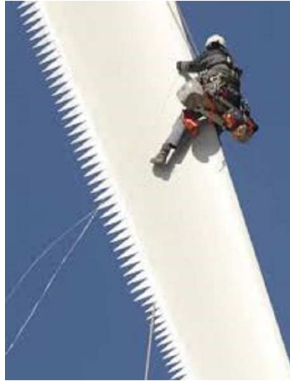
Figura 3.22: Operatore al lavoro sulla GE94 durante la pulizia dei profili.
