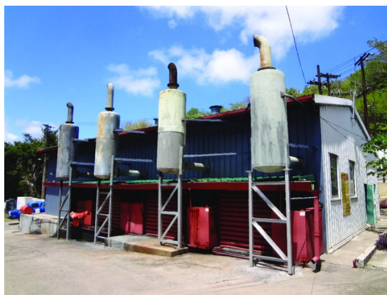
Figura 8.1: Tipico gruppo elettrogeno a gasolio in uso nelle isole.
