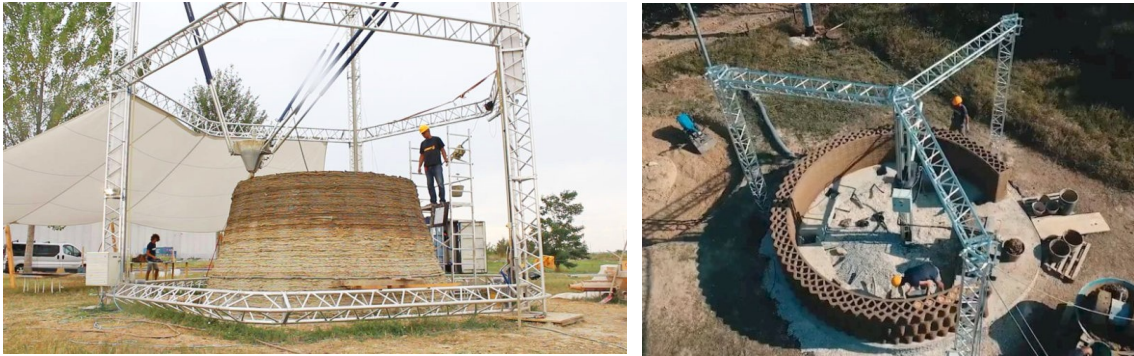
Figura 1.13 - Sistemi di estrusione WASP: (a) "Big Delta"; (b) "Crane"
