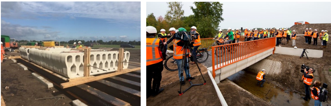
Figura 1.17 - Ponte ciclopedonale in calcestruzzo estruso, Gemert (Paesi Bassi) - Eindhoven University of Technology (2017)
