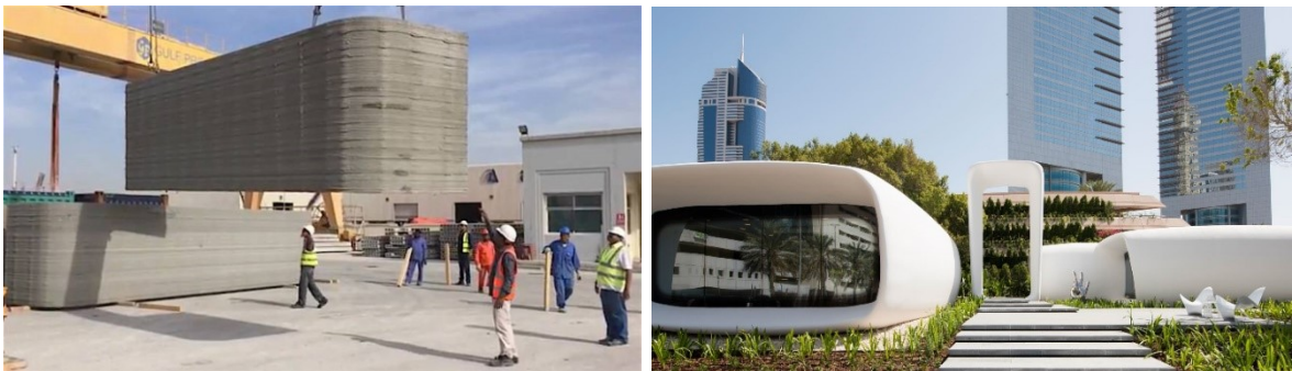
Figura 1.1 - "Office of the future", Dubai. Posa in opera di elementi modulari.
