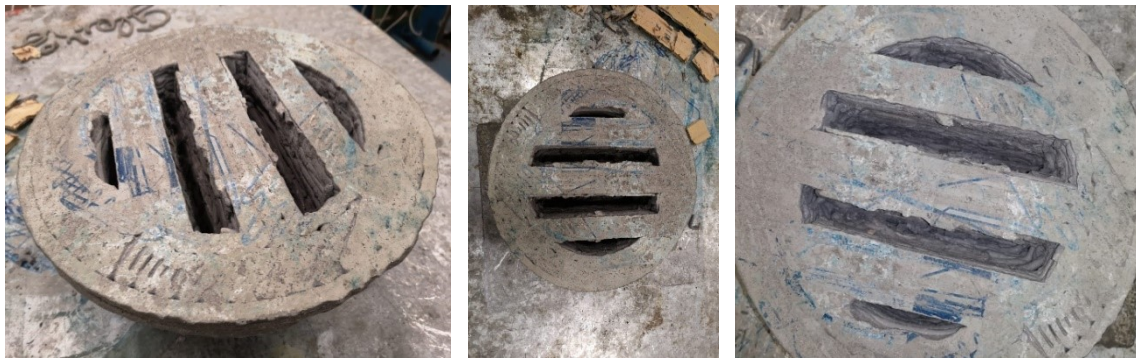
Figura 10.12 - Particolare delle cavità interne
