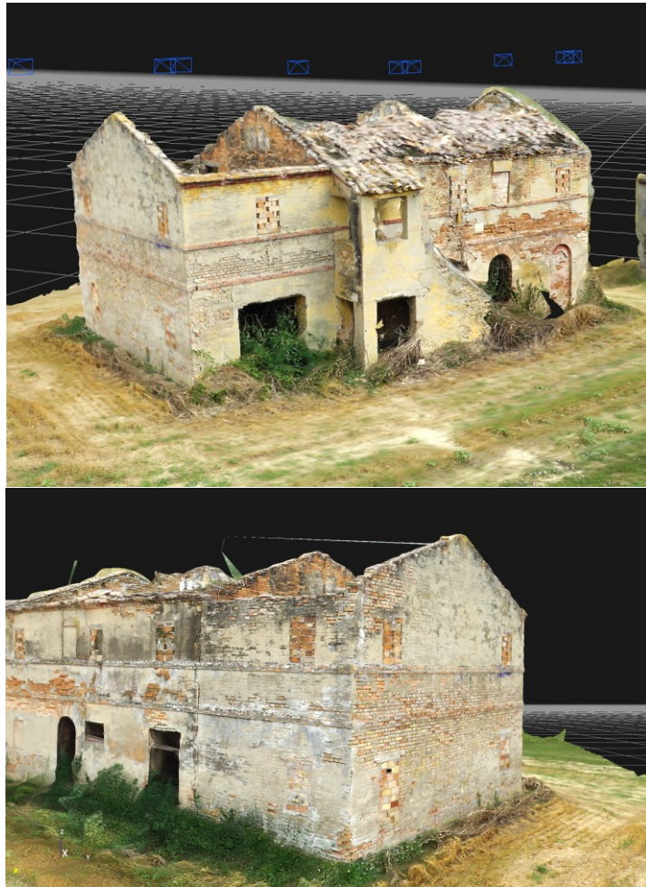
Figura 5.1-10: Ricostruzione 3D attraverso missione da SAPR
