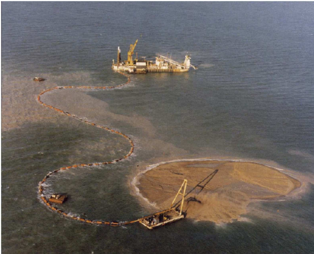
Figura 25: Draga aspirante/refluente stazionaria con disgregatore “Leonardo da Vinci” durante i lavori di riempimento per la realizzazione del ponte Storebaelt (Danimarca) (Bray et al. 1996).
