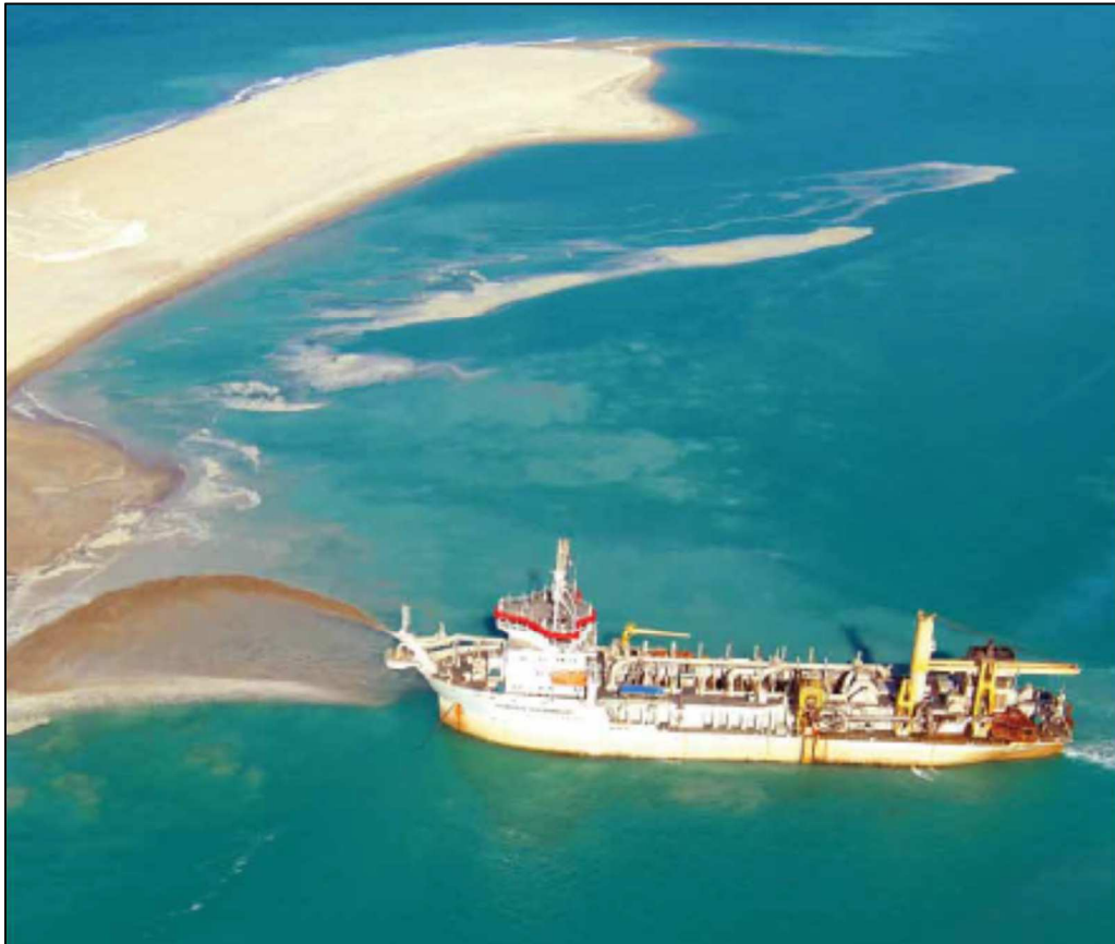
Figura 27: Draga aspirante semovente con pozzo di carico “Alexander von Humboldt” durante i lavori di land reclamation di Palm Jebel Ali Island a Dubai (Emirati Arabi Uniti).
