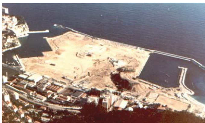
Figura 52: Montecarlo, fasi di riempimento dell'area.
