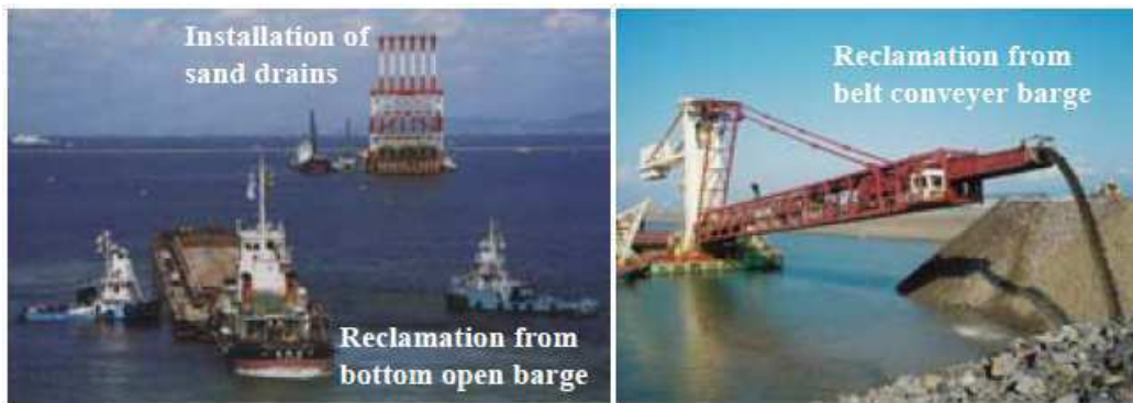
Figura 49: Osaka, prime fasi di costruzione dell'isola (Cianca 2015).
