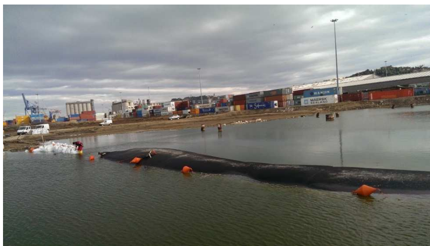
Figura 91: Posizionamento dei sacchi all'estremità del tubo sul lato terra (gennaio 2017).
