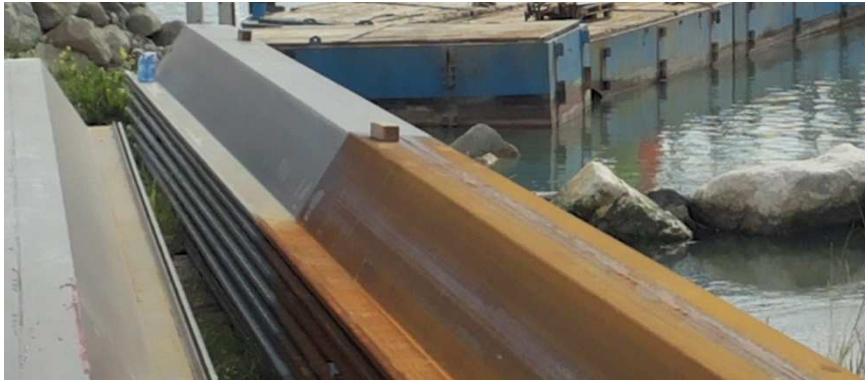
Figura 67: Rivestimento epossidico per le palancole lato mare.
