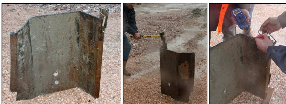
Figura 66 Prova di funzionamento sistema Dixeran in cantiere.
