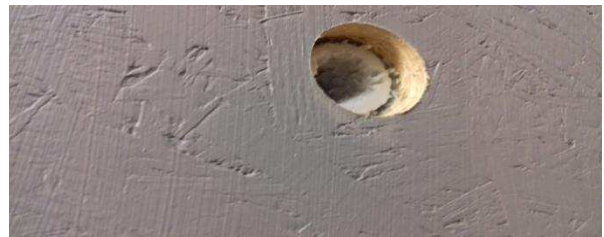
Fig. 11 Cap. 7 - foro per il passaggio cavi
