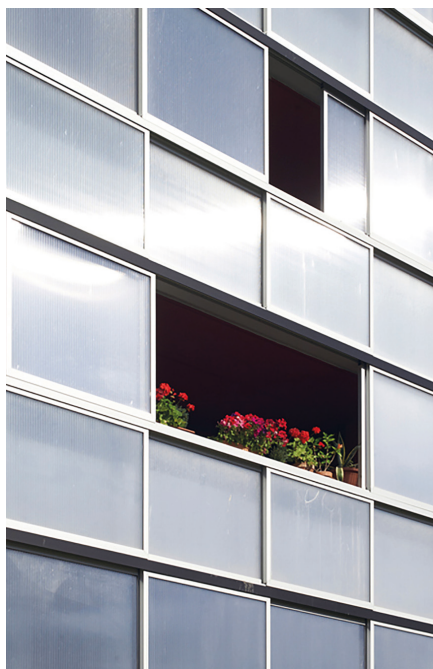
Sopra e destra: Riqualificazione urbana a Lormont (viste)
