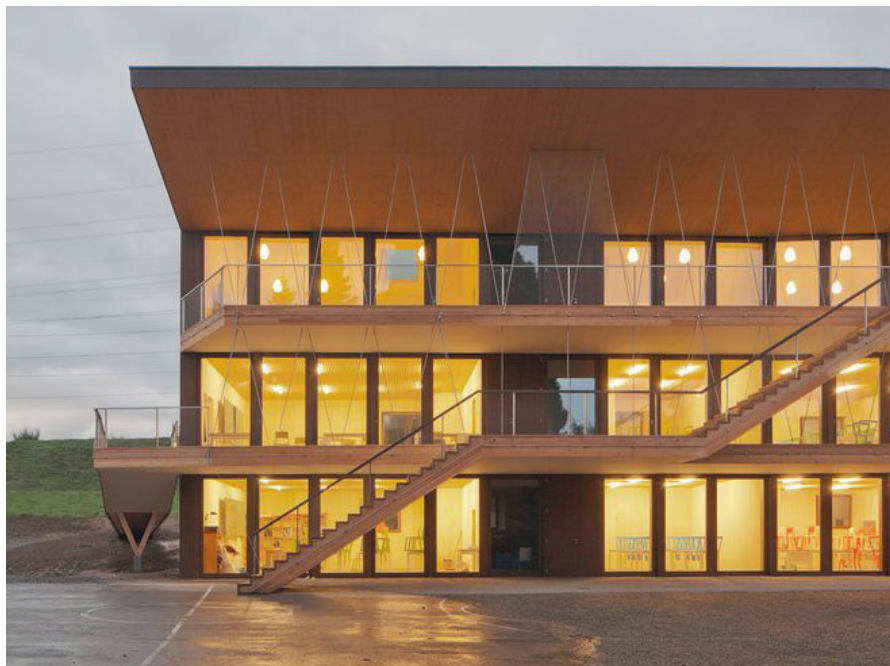
Edificio scolastico di Bois-Genoud - Viste d'insieme
