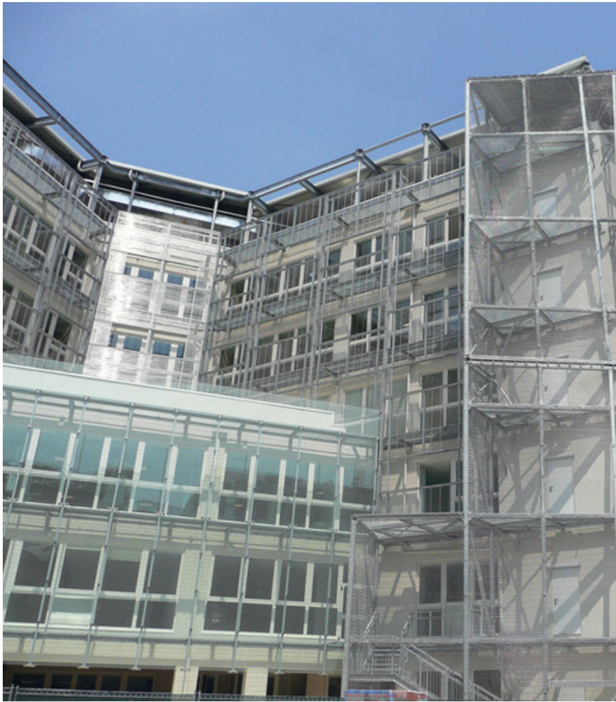
Nuovo Padiglione Manteggia - Vista esterna
