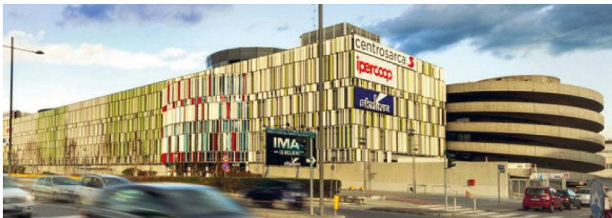
Centro Sarca (prima e dopo dell'intervento)
