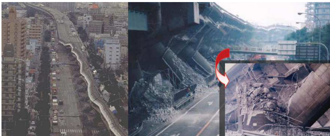
Figura 2-2 – Cerniere plastiche alla base delle pile durante il terremoto di Kobe, Giappone 1995
