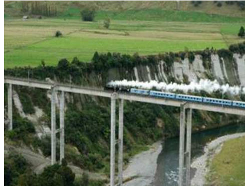
Figura 2-14 – Ponte Rangitikei in Nuova Zelanda, primo ponte isolato sismicamente
