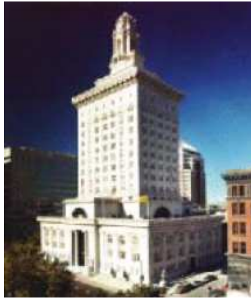
Figura 2-16 – City Hall di Oakland
