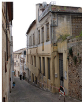
Laboratorio abbandonato centro storico
