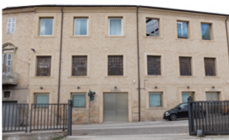
fabbrica storica recuperata
