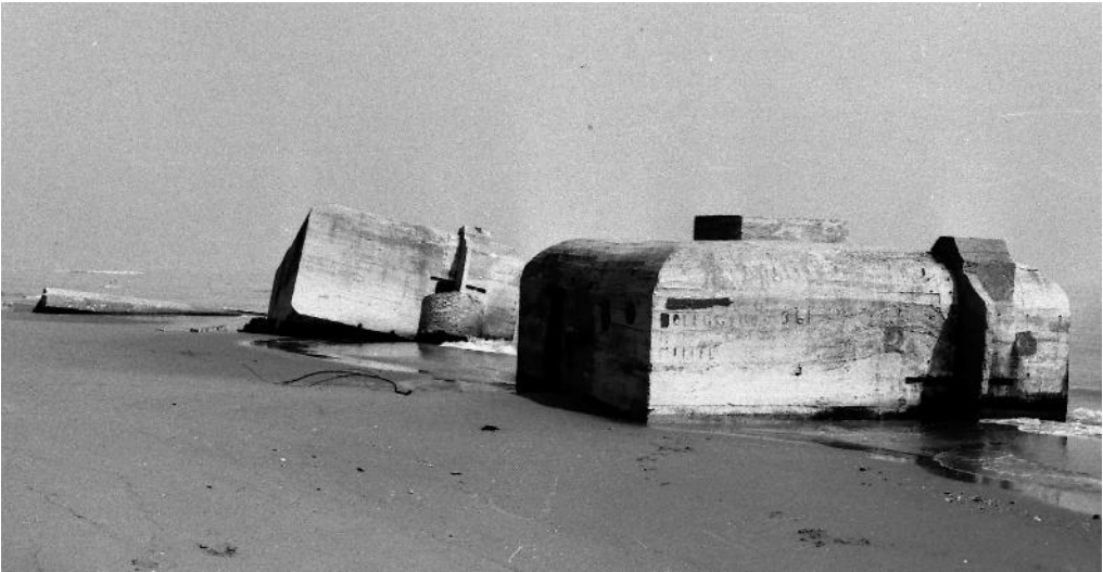
1: Lido di Savio (RA). Bunker abbandonati sulla spiaggia, 1971. [Photo courtesy CRB 360°]
