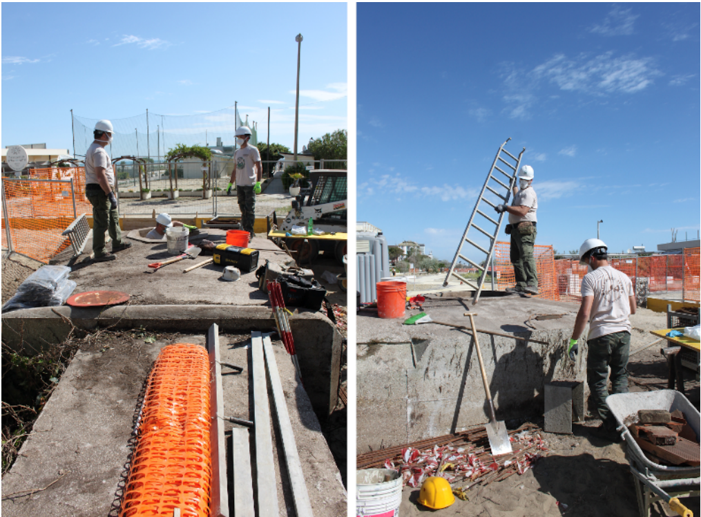
3: Cervia (RA). Membri dell'Associazione CRB360° durante i lavori di riapertura di un bunker [Foto degli autori].
