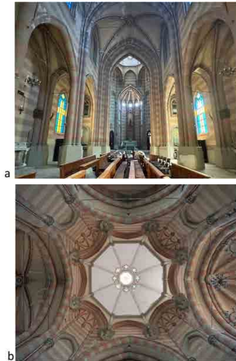
Fig. 3 – Interno dell'aula della Chiesa di Santa Maria di Piazza (a), dettaglio della cupola vista dall'interno dell'edificio (b).
