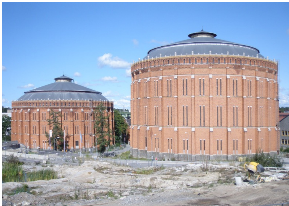
3: Ferdinand Boberg, i gasometri dopo l'intervento di restauro, Stoccolma 2021. Foto dell'autore.
