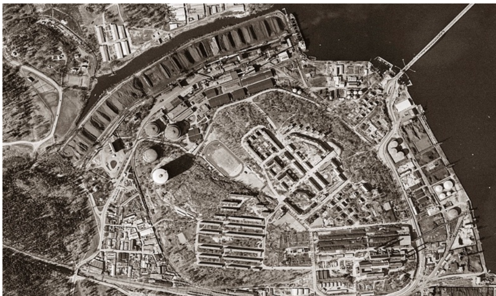
4: Vista aerea di Värtagasverket nei primi anni sessanta (fonte https://commons.wikimedia.org/wiki/File:Värtagasverket,_Hjorthagen,_1960-tal.jpg , immagine libera di diritti, ultimo accesso dicembre 2023).
