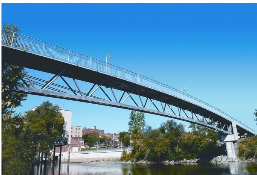
Figura 2 - Ponte pedonale di Sherbrooke, Canada
