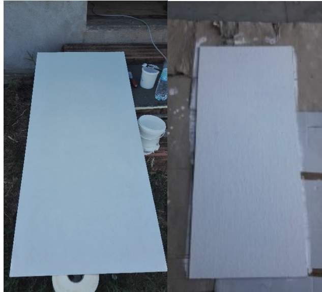
Fig. 100 – Fasi applicative delle pitture sui pannelli OSB prima di essere installati.
