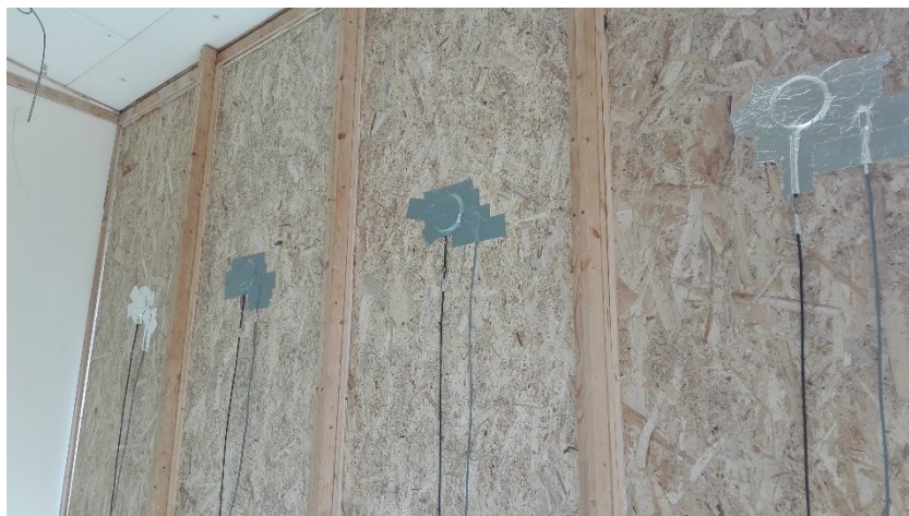
Fig. 104 – Installazione dei termoflussimetri per ciascun pannello: termoflussimetri e sonde di temperatura PT100 devono essere collocati alla stessa altezza e uno accanto all'altro.
