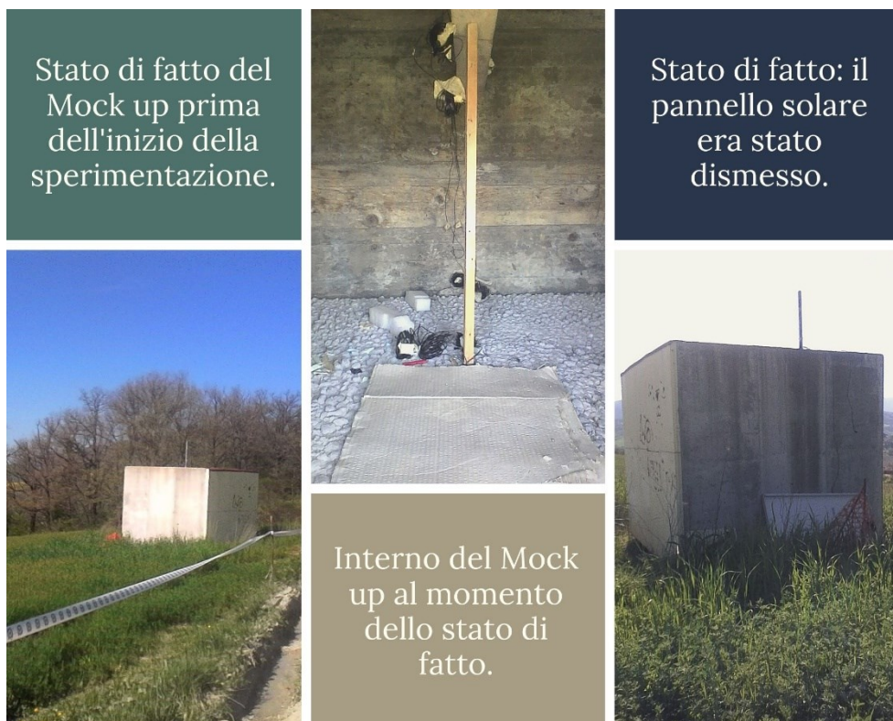
Fig. 44 – Sopralluogo Mock up prima dell'inizio della sperimentazione per individuare le problematiche da risolvere e pianificare l'avvio campagna.
