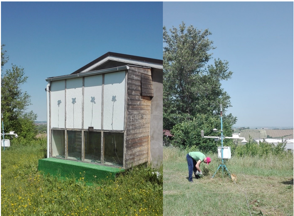
Fig. 105 – Stazione meteo posizionata adiacente al mock up sperimentale: nella foto le varie fasi di allestimento preparatorie all'inizio della campagna di monitoraggio.
