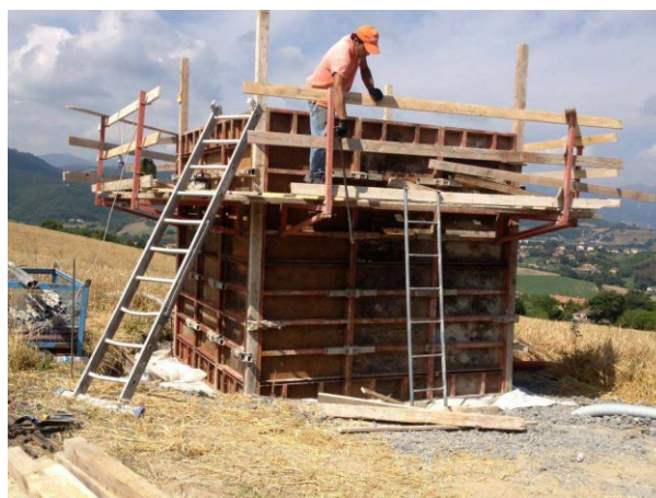
Fig. 43 – Predisposizione della cassetta per il getto in cls Misapor Beton.
