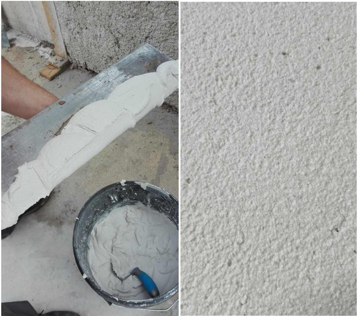
Fig. 90 – Applicazione del rasante R1 su un muretto sul quale era stato applicato precedentemente il termointonaco a base sughero. Obiettivo: valutare l'applicabilità e lavorabilità del prodotto, grado di finitura finale e resistenza agli agenti atmosferici (il muretto era all'esterno e non protetto).
