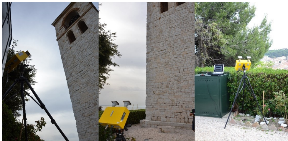
Figura 68 – Campanile di San Ciriaco – Radar interferometrico nella fase di acquisizione
