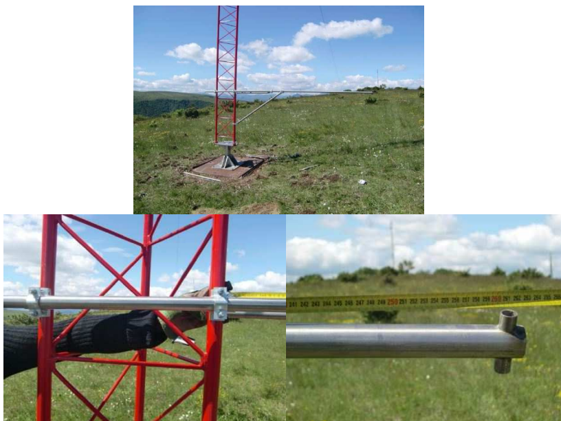
Fig. 8: Dettagli dei braccetti di supporto per gli strumenti prima della loro installazione
