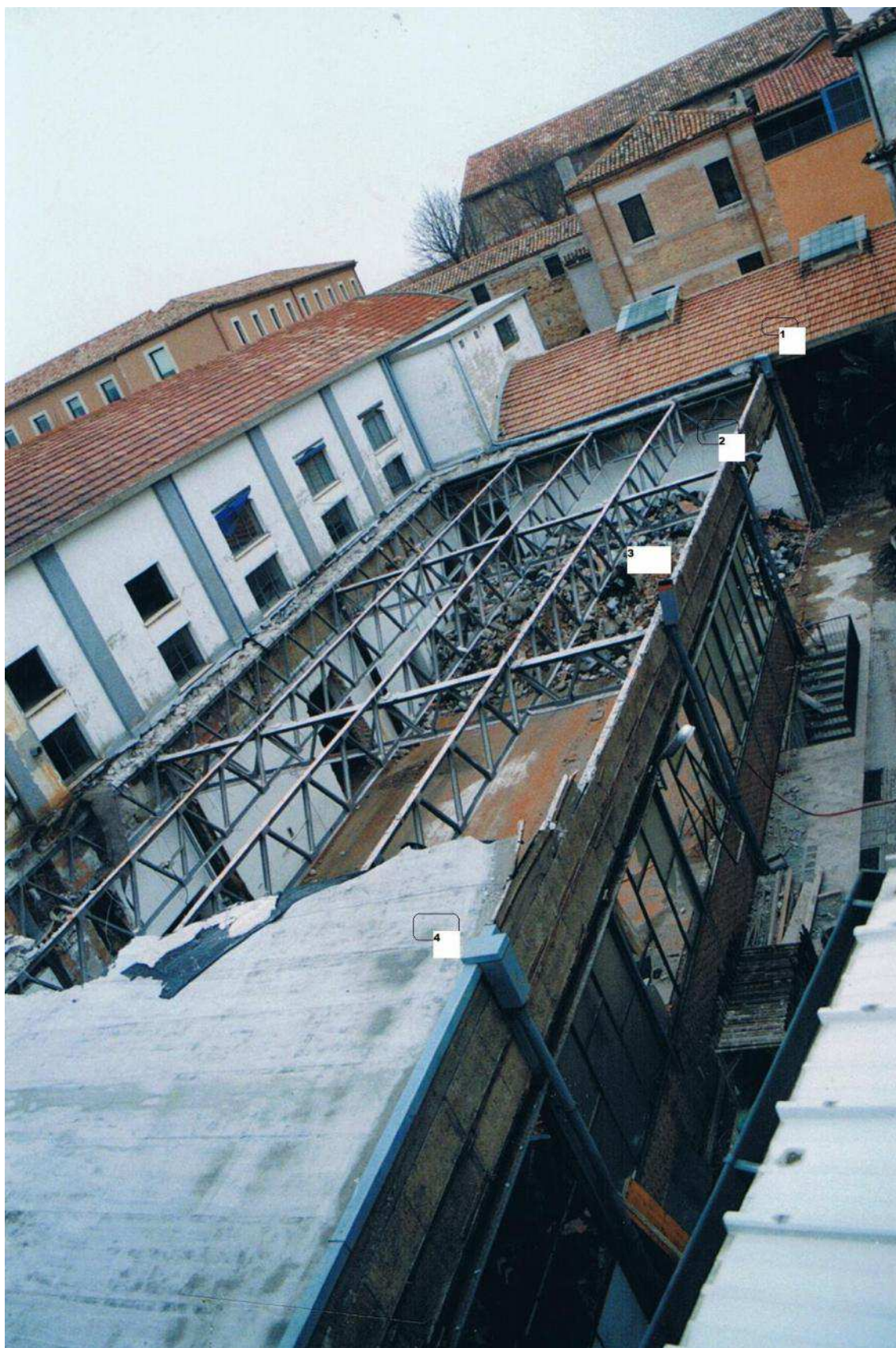
I lavori di demolizione del capannone Ex-Icomas (foto Ing. Russo)
