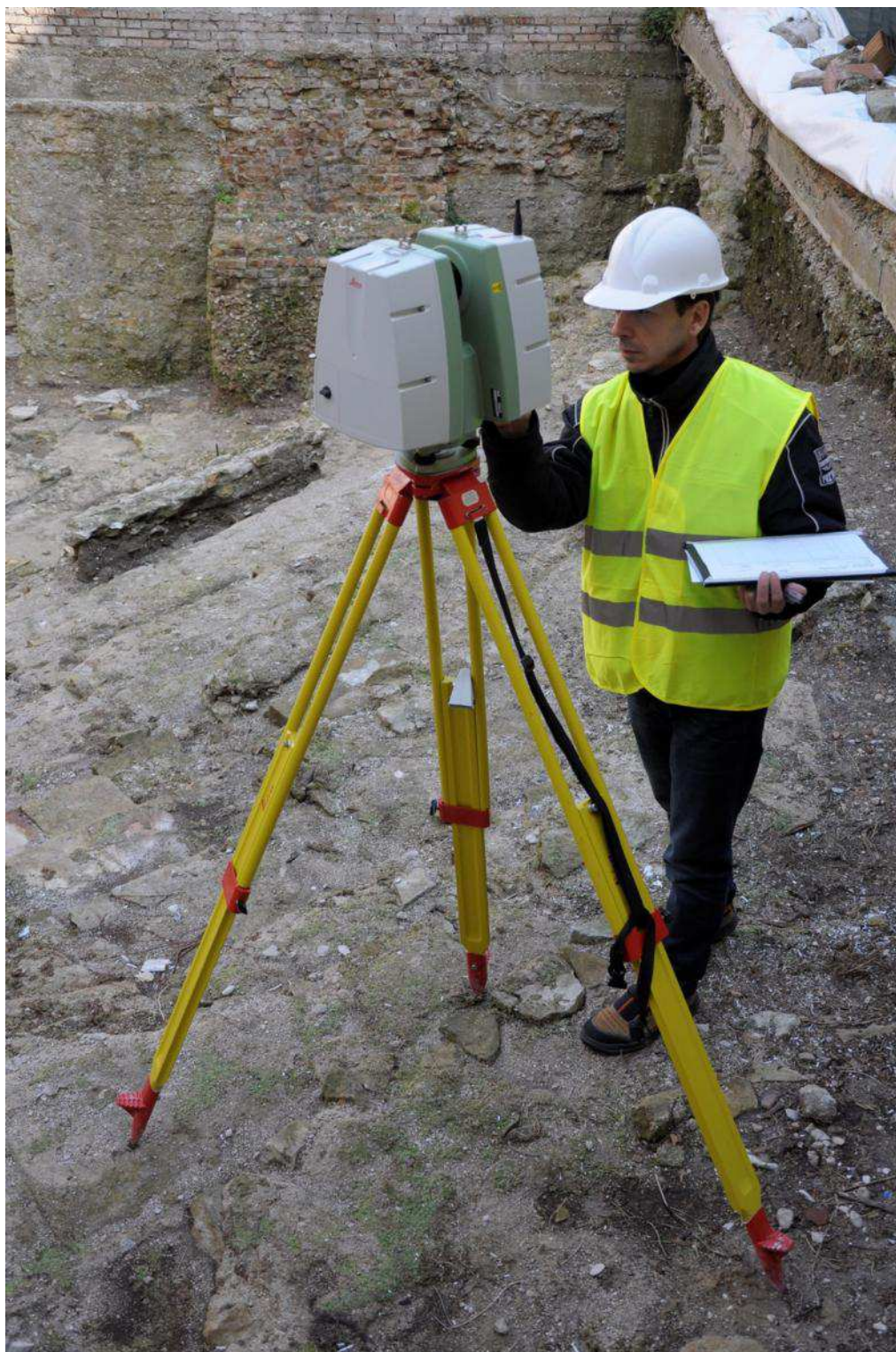
Fig. 69. Una fase dei rilievi del teatro ad opera dei tecnici dell'Univpm
