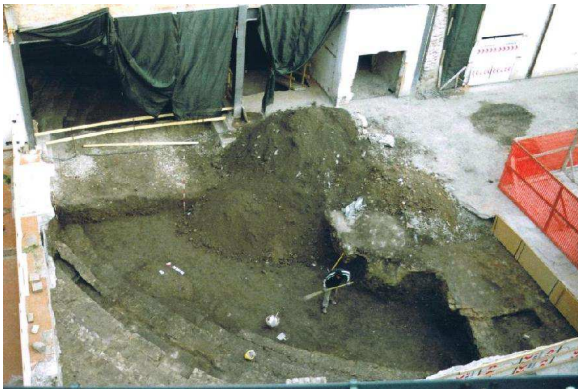
Prime operazioni di scavo con l'individuazione della cavea
