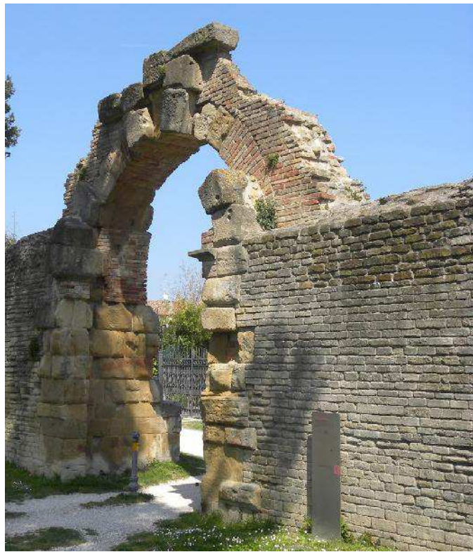
Fig. 41 – Porta della mandria con in evidenza il paramento murario in opus vittatum
