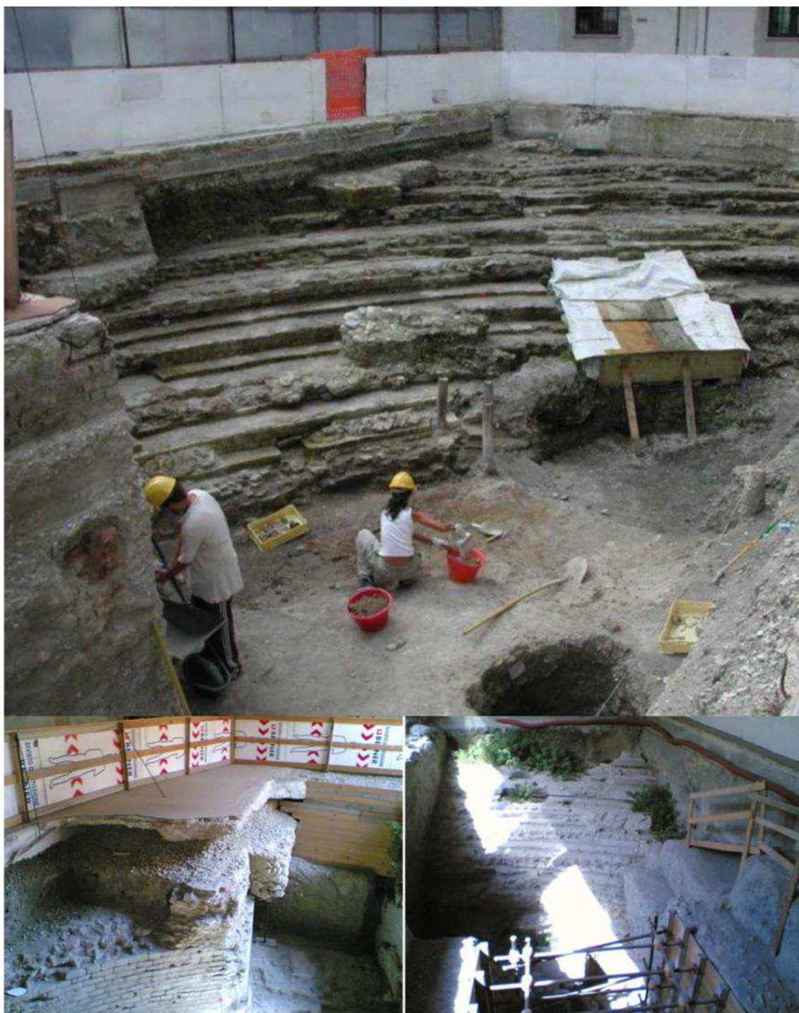
Operazioni di scavo
